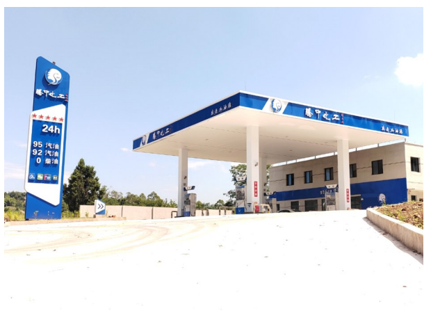
鹤游加油站项目建设完工。
