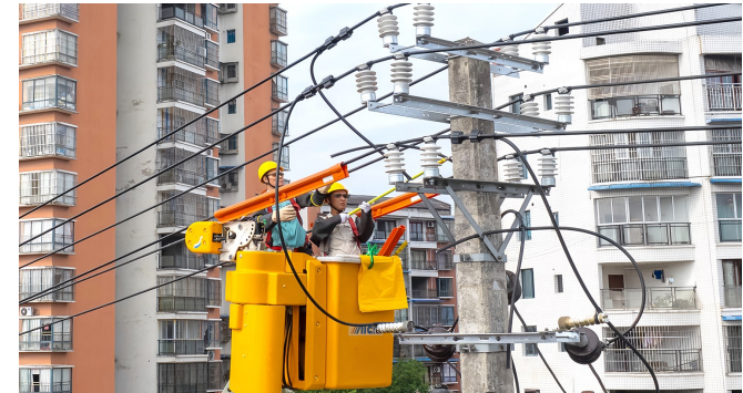
作业人员正在高空进行作业。
