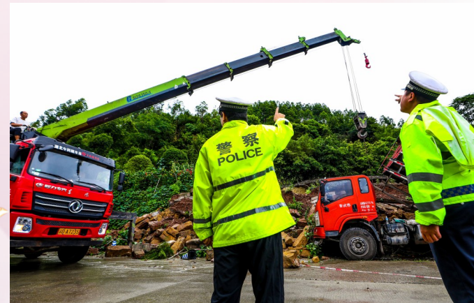
桂阳街道联合交巡警开展天宝寨滑坡治理。
