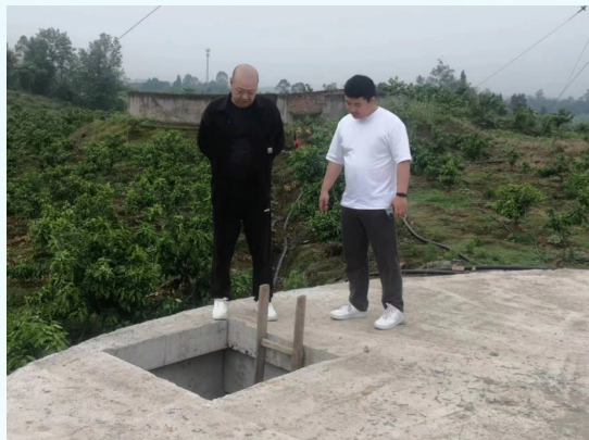
工作人员检查高安镇抗旱提水工程
