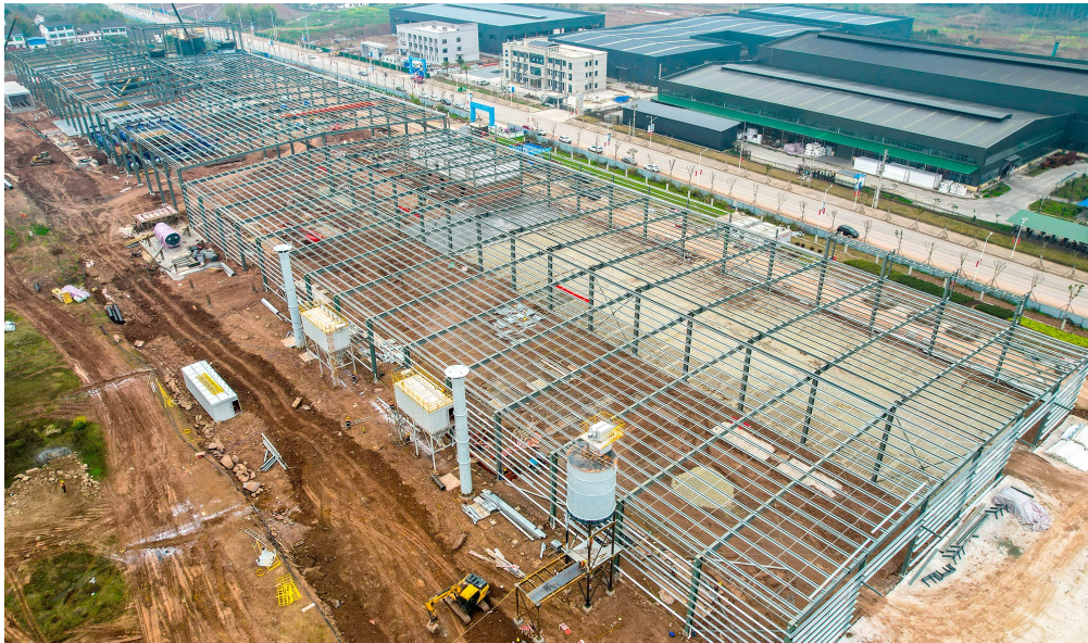
中材渝建厂房正在施工建设。记者 龚长浩 摄
