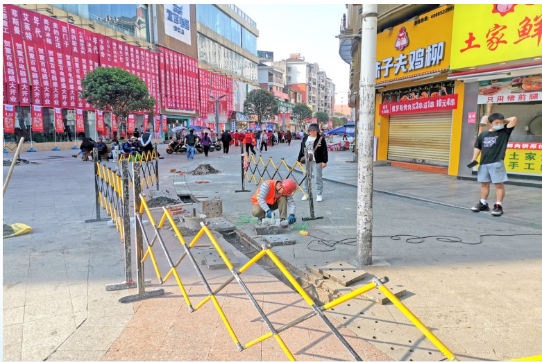
道路设施品质提升工程
